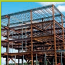
Oceľové konštrukcie AVG pre viacúčelové objekty
