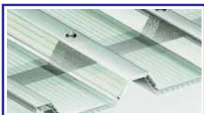
DETAILNÝ POHĽAD UPEVNENIA A BOČNÉHO NAPOJENIA MEDZI PRESVETLOVACÍMI PANEĽMI
