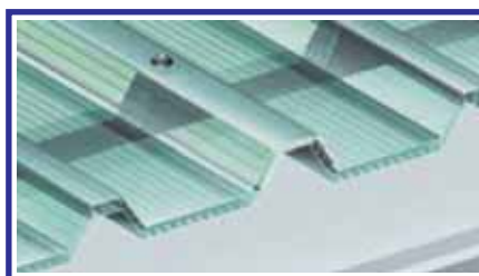
DETAIL BOČNÉHO NAPOJENIA MEDZI DVOMI POLYKARBONÁTOVÝMI PANELOMI
